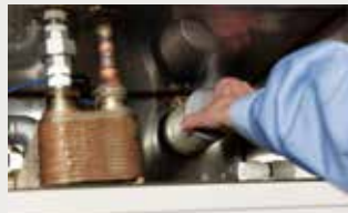
上方水槽内设置有杂质过滤网清扫及给水方便
