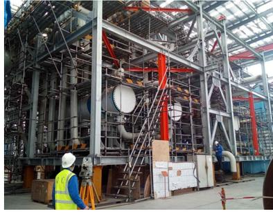
大型化工模块尺寸控制（检控钢构部分，设备，管口）综合尺寸控制，确保现场模块各项拼接精度。
