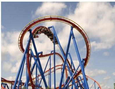
过山车构件法兰对接，单构件空间角度复杂，实物预拼场地受限，通过三维精度检测加虚拟拼装应用，有效保证整体建造精度。
