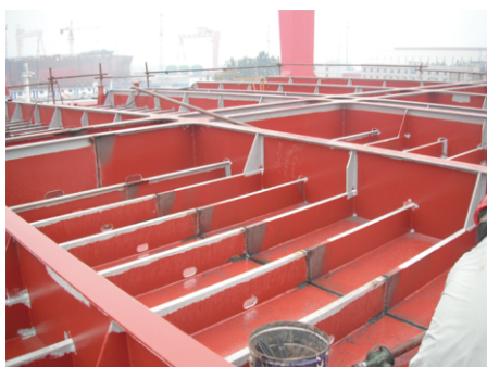
定位过程中的水平度检测
